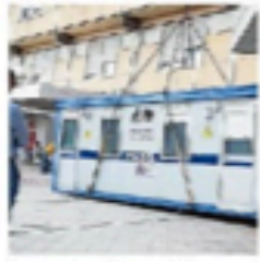
Il container viene posizionato
